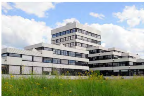
Abb. 08: Anwendungszentrum Industrial Automation (INS) in Lemgo
