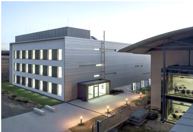
Abb. 36 Mit der »E 3 -Forschungsfabrik Ressourceneffiziente Produktion« baut das Fraunhofer IWU seine Kompetenzen im Bereich der Energie- und Ressourceneffizienz zum Campus E 3 -Produktion am Standort Chemnitz weiter aus.
