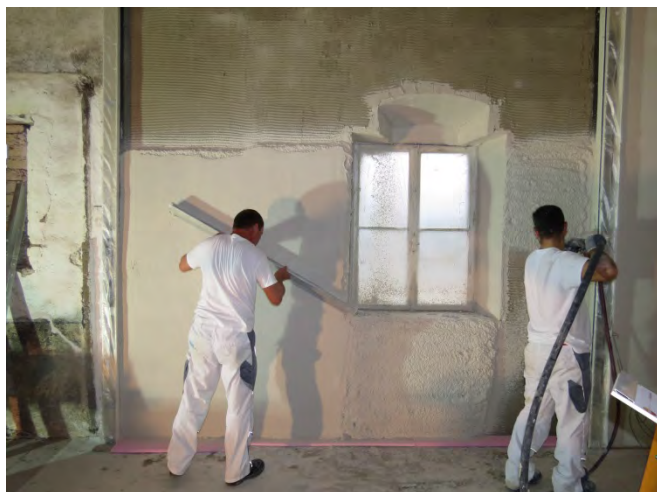
Abb. 52 Fraunhofer-Zentrum für energetische Altbausanierung und Denkmalpflege Benediktbeuern: An der wertvollen historischen Bausubstanz der »Alten Schäfllerei« im bayerischen Kloster Benediktbeuern werden innovative Materialien zur Innendämmung angebracht.
