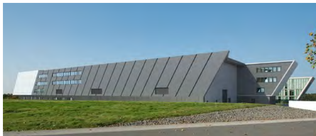
Abb. 18 Neubau des Open Hybrid LabFactory e.V. in Wolfsburg.
