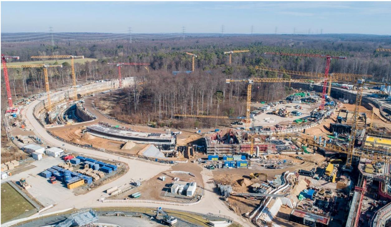
Ausbau des **GSI Helmholtzzentrums für Schwerionenforschung** zu einem internationalen Beschleunigerzentrum für die Forschung mit Ionen- und Antiprotonenstrahlen FAIR (Facility for Antiproton and Ion Research). Kernstück wird der hier abgebildete mit supraleitenden Magneten ausgeführte Doppelringbeschleuniger mit einem Umfang von 1083,6 Metern.
